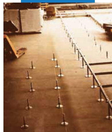
Перекрытие, выровненное с помощью Ultraplan (Ультраплан)
