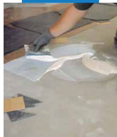
Пример укладки ПВХ поверх выравнивающего слоя Ultraplan (Ультраплан)
